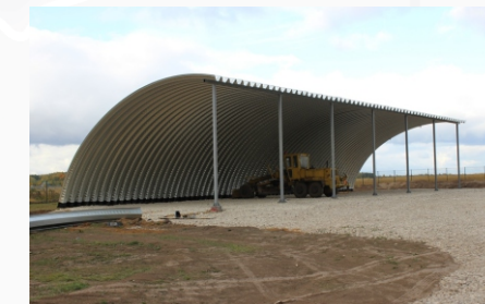
Тульская область, Веневский район, с. Козловка Строительство бескаркасного навеса для техники.
