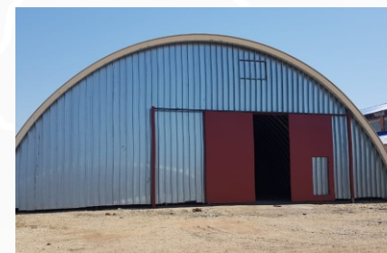
Республика Адыгея, Теучежский р-он, пгт. Телюстенхабль. Строительство бескаркасного зернохранилища.
