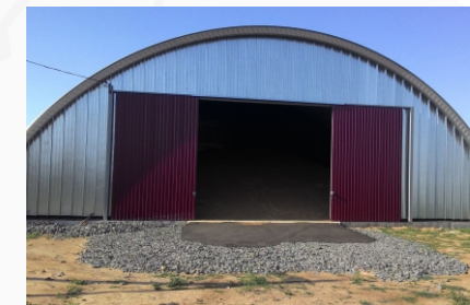
Ростовская область, Зимовниковский район, пос. Ленинский Строительство бескаркасного зернохранилища
