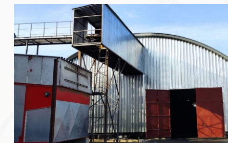
Волгоградская область, Руднянский район, пос. Рудня Строительство бескаркасного зернохранилища.
