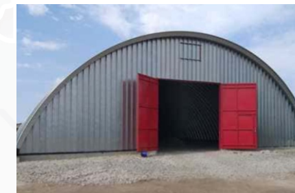
Ростовская область, Милютинский район, пос. Аграрный Строительство бескаркасного зернохранилища.
