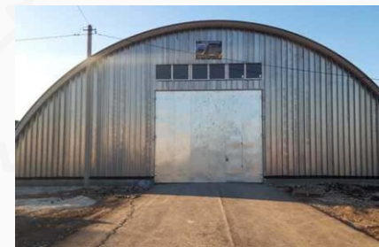
Волгоградская область, Палассовский район, с. Ромашки Строительство бескаркасного зернохранилища.
