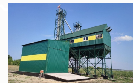
Саратовская область, Романовский район, пос. Мордовский Карай Строительство зерноочистительного комплекса ЗАВ-80
