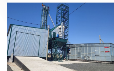
Волгоградская область, Кумылженский район, х. Попов Зерноочистительный комплекс ЗАВ-80 1-я очередь.
