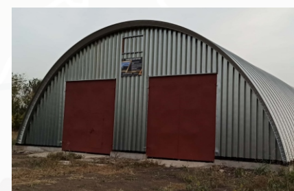
Краснодарский край., Кавказский район, х. Лосево Строительство бескаркасного зернохранилища.
