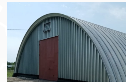
Саратовская область, Саратовский район, пос. Сергиевский Строительство бескаркасного зернохранилища.
